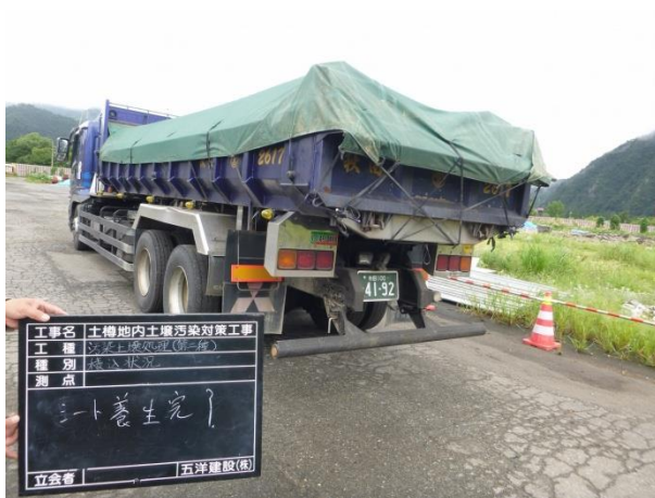
写真 5-29 シート養生状況
