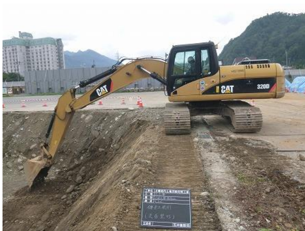
写真 5-19 非汚染土壌掘削状況 (D4-8)
