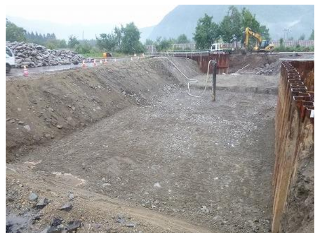
写真 5-18 汚染土壌掘削完了
