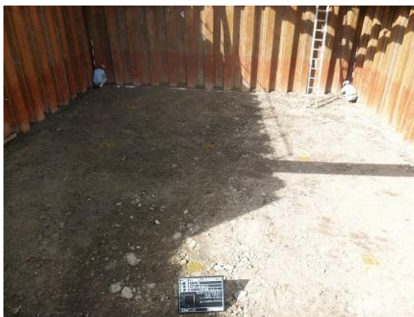
写真 5-15 汚染土壌掘削完了 (D3-5) 状況
