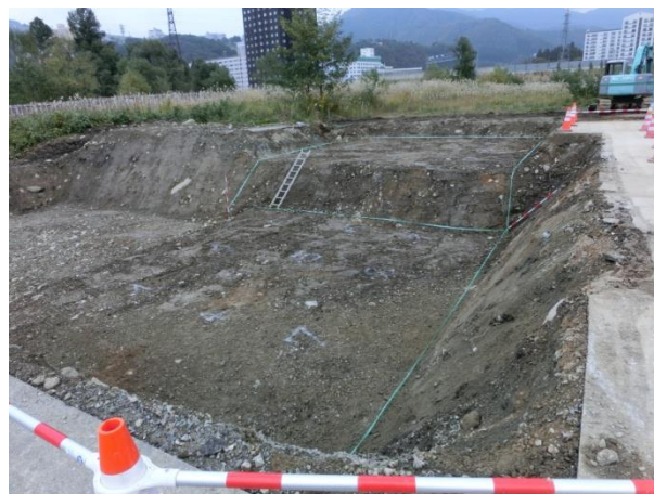
写真 5-20 非汚染土壌掘削完了
