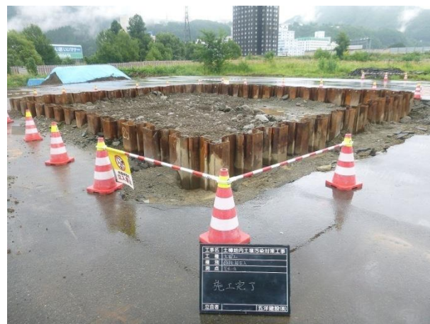
写真 5-8 鋼矢板打設完了 (E4-4)
