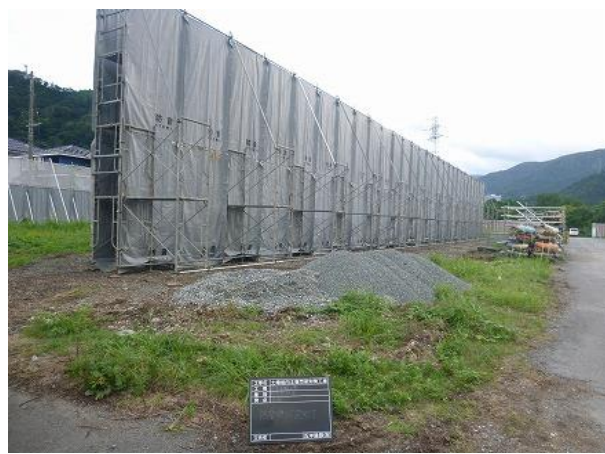
写真 5-6 足場組防音壁
