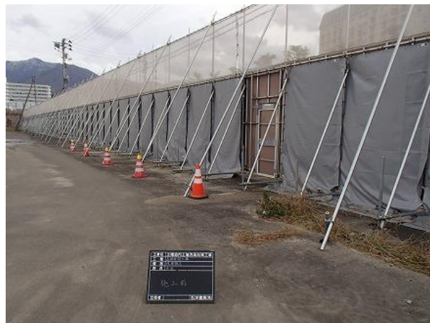
写真 5-2 敷地南側：仮囲い（H＝5.0m）
