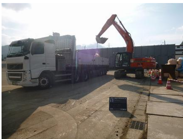
写真 5-17 フレコンバック積込状況 (E3-6)
