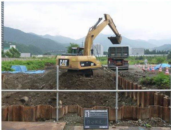
写真 5-13 汚染土壌積込状況
