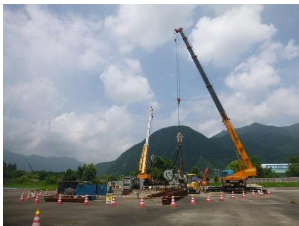
写真 5-7 鋼矢板打設状況 (D3-5, E4-4)
