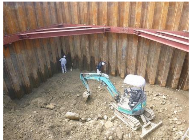
写真 5-14 汚染土壌床付状況
