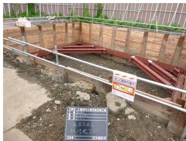
写真 5-10 土留め支保工設置完了
