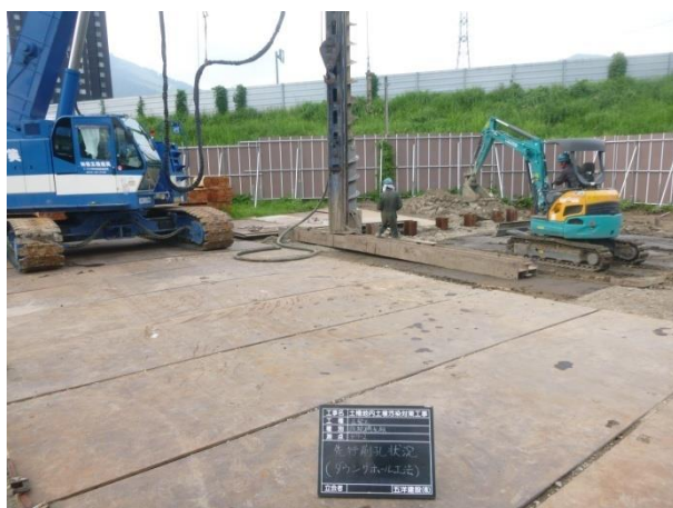
写真 5-9 親杭打設状況 (F9-2) (F9-2)
