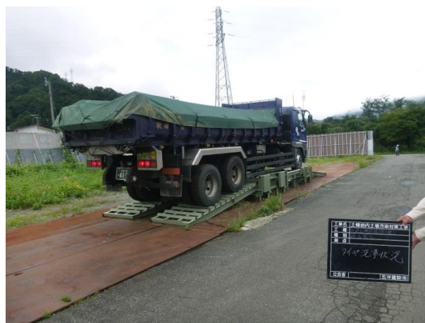
写真 5-30 タイヤ洗浄状況
