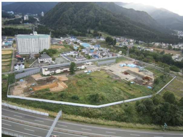
写真 5-1 直接仮設工事全景
