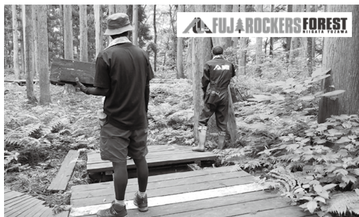
フジロックの森エリア内でのボードウォーク整備状況
