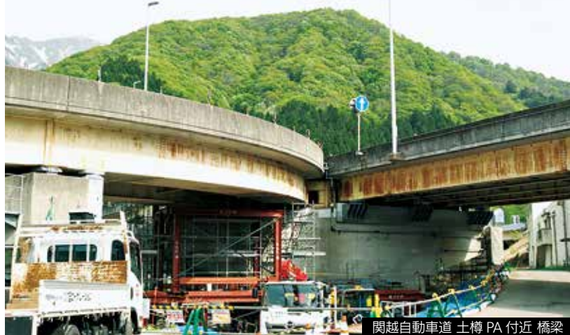
関越自動車道 土樽 PA 付近 橋梁
