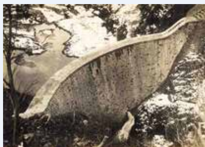
↑竣工直後（昭和14年）の堰堤を右岸から望む。（土砂が堆積していないため、最下段の暗渠から水がながれています。）
