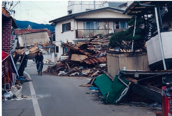
地震後の道路閉塞の状況
