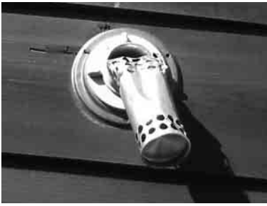
危険！FF式温風ヒーターの排気筒の破損。必ず点検しましょう。
