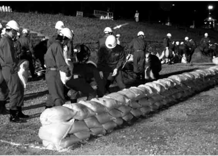
5月27日夜、立柄橋下流の魚野川右岸河川敷で、魚野川夜間水防訓練が実施されました。この訓練は、信濃川・魚野川水防連絡会の主催で毎年行われ、国、県、市町や川口町、魚沼市、南魚沼市そして湯沢町の消防団が参加しています。この日の訓練は、まず各消防団により積み土の工（写真左）、木流し工、シート張り工と行われ、最後に国土交通省による排水ポンプ車排水と、コンクリートブロック投入工法が行われました。近年は日本全国で、梅雨前線や台風による水害が頻発しています。そして水害は、昼夜を問わず発生します。雨のシーズン前に対処して夜間訓練を行うことは、災害に対する万全の備えを整える上で、とても重要なことといえます。
