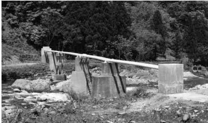
魚野川の旧万年橋にかかる送水管。かつて土樽と神立を結んだ橋は、現在湯沢地区などに水を運ぶ「水の大動脈」となっています。
