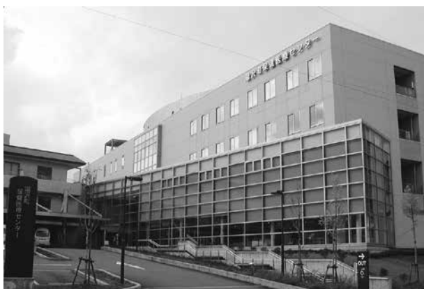
湯沢病院の病床転換
