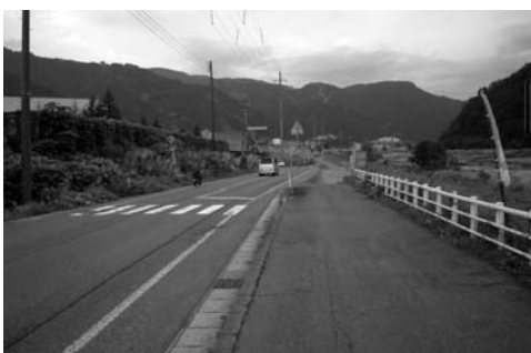
東山線高速道路下から立柄橋間の改良
