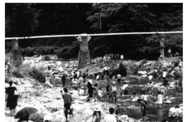
現在では、写真のように土樽地区の水を水道水として使用するための導水管を渡すための一役かっているが、橋脚として使っていた部分が原形を残しており、橋があったことは歴然としている。
