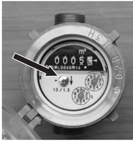
冬期間、水道メーターを検針しないと、漏水していても漏水が発見できない場合があります。そこでメーターの確認をおすすめします。家の水道の蛇口を全部閉めてから、メーターの文字盤にあるパイロットを見てください。少しでも回っていれば漏水の可能性があります。
