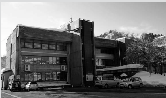
役場庁舎東館の耐震補強工事
