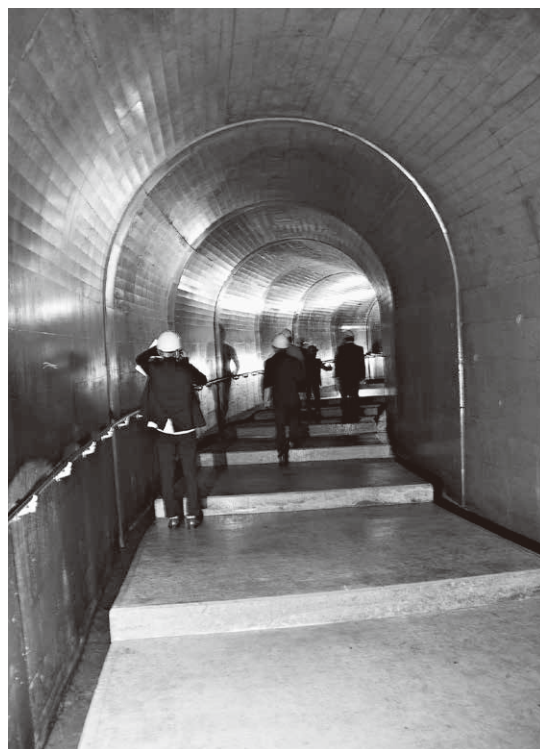
排水トンネル
