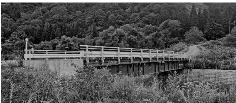
下流からの橋梁
