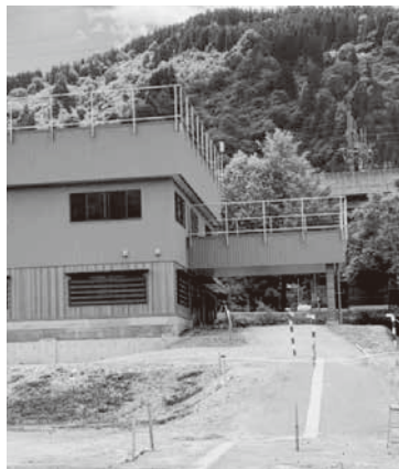
エントランス棟
