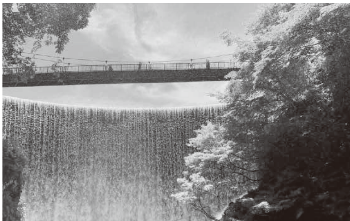
大源太砂防堰で排水溝から見える景色
