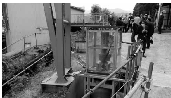
令和2年産建視察 小水力発電(富山)
