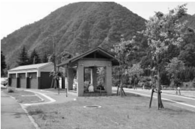
中央公園が完成しました
