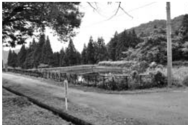
旭原地内用水池
