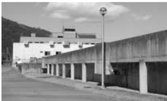
10年計画で施設改修予定の湯沢浄化センター
