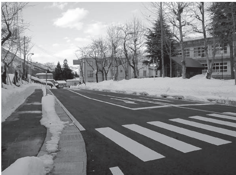
段差が解消された主水公園付近の歩道
