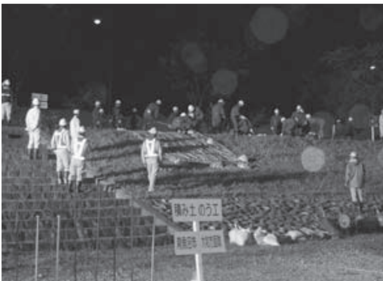
立柄橋下流で行われた魚野川夜間水防訓練
