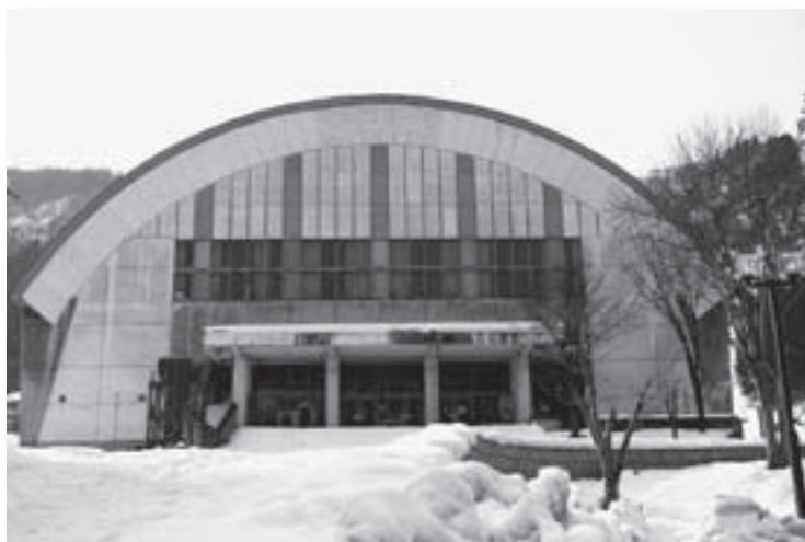
夏季観光に大きく貢献しているロープウェー体育館
