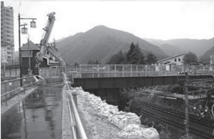
今年12月完成予定の中里 JR こ線橋 船沢橋
