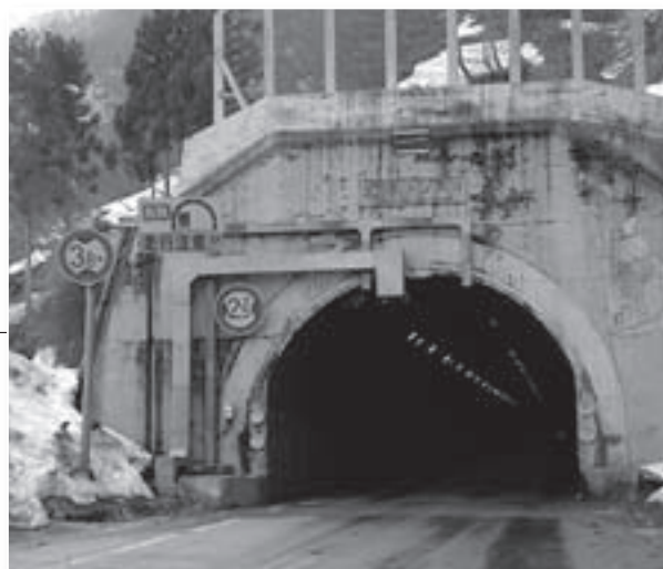
芝原トンネルの建設について 今後の要望活動展開は
