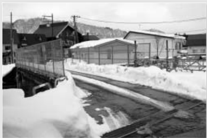
今秋完成予定の土樽・越後中里間 線橋
