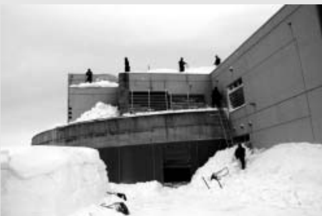
自衛隊による除雪作業（三国小学校）
