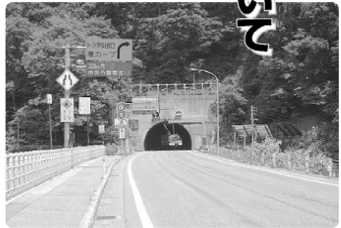
三俣地域振興対策の中で新たなトンネル建設が要望されている芝原トンネル
