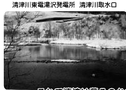
清津川東電湯沢発電所 清津川取水口
