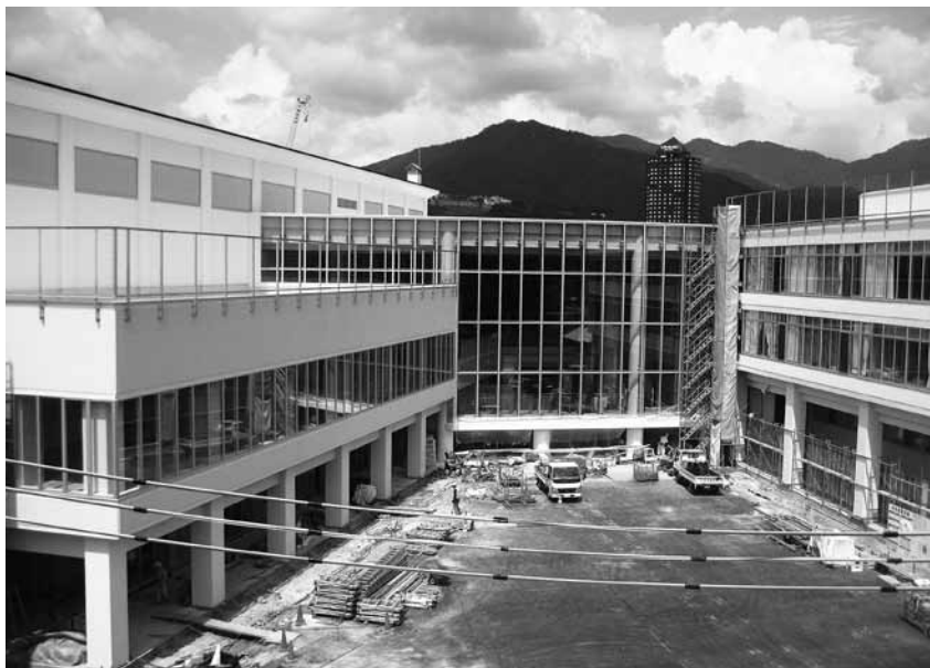
工事中の湯沢学園
