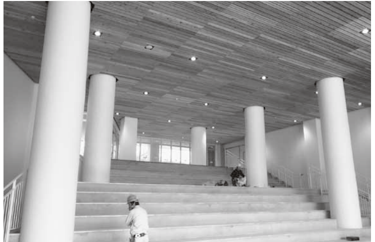
建築基準法の改正により、構造が強化された湯沢学園いりろい広場天井
