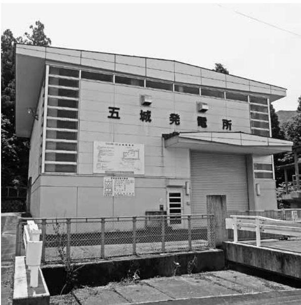
五十沢地区小水力発電所
