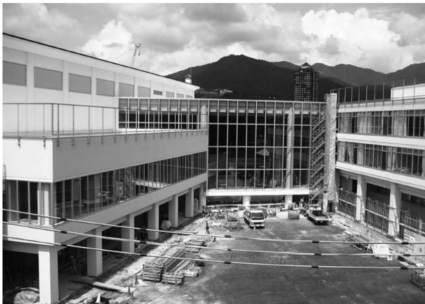
工事中の湯沢学園
