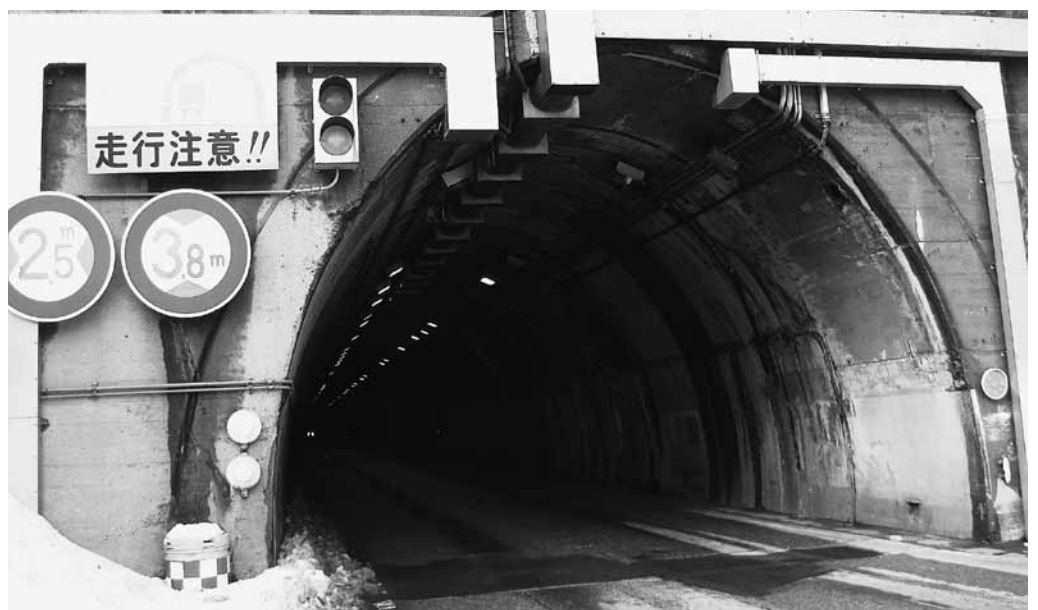
大型車両のすれ違いが大変な二居トンネル
