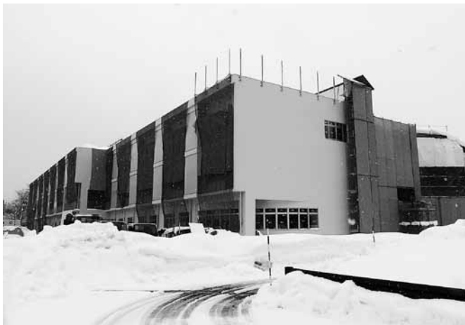
建設中の湯沢学園
