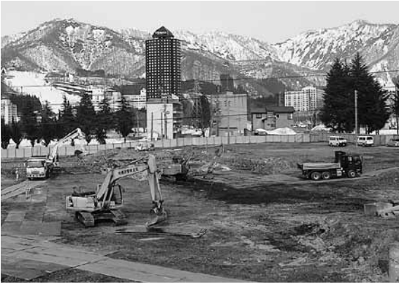
建設中の湯沢学園（平成25年4月）
