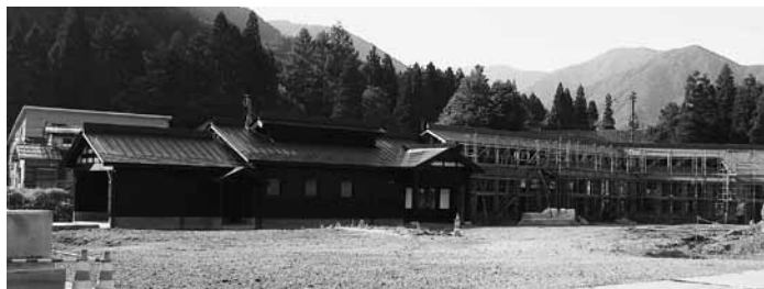
建設中の「道の駅みつまた」
