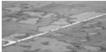
▲劣化テニスコート
