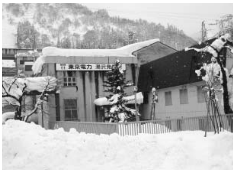
東京電力 湯沢発電所
