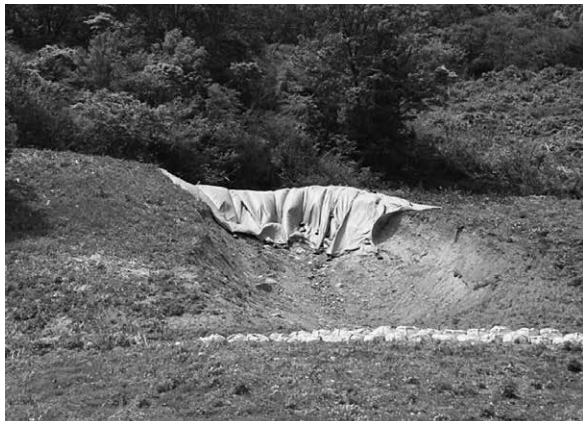
旧布場スキー場斜面崩落箇所
