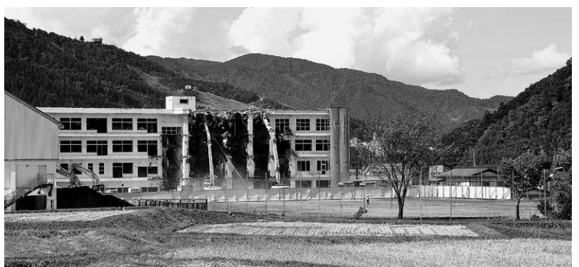
旧湯沢小学校解体
