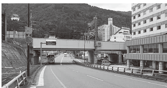
城平線跨線橋補修、消パイ打替 1億4,955万円
