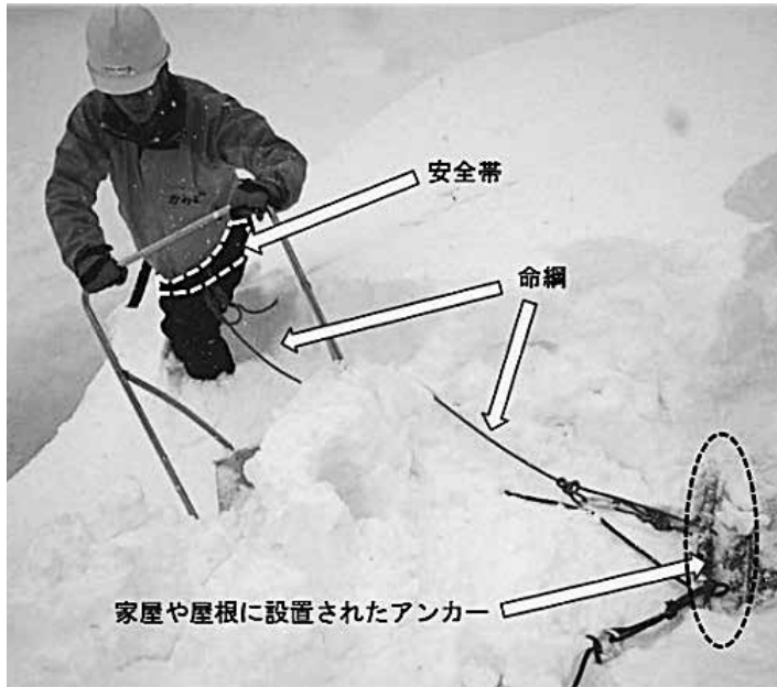
安全帯、命綱、アンカーを使用した雪下ろし作業
