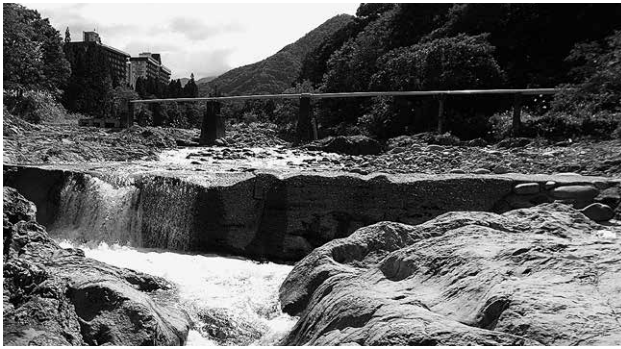
万年橋：崩れた堰堤に集中する水の流れ
