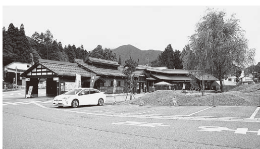
道の駅みつまた バックヤード建築 1,311万円
