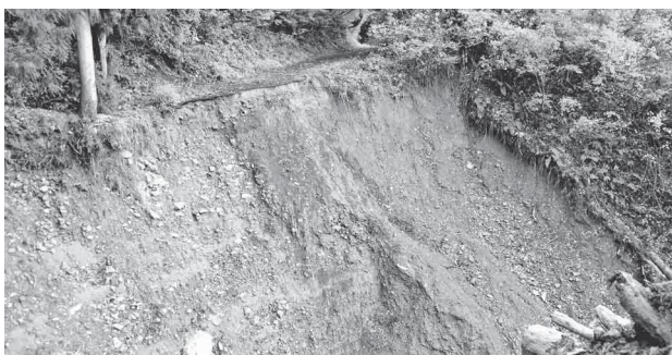
古野蓬線、土砂崩れ現場
