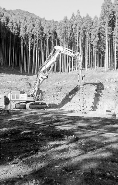
浅貝砂防ダム工事
