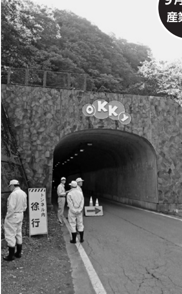
奥清津トンネル
