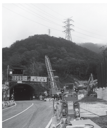
工事中の三国トンネル
