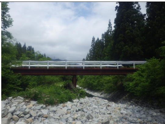
写真全景（鋼橋）
