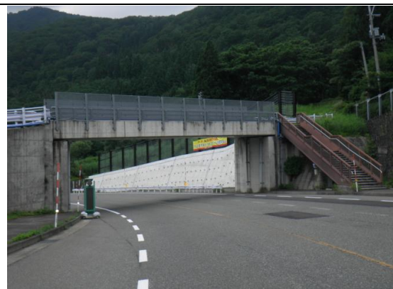
写真全景（コンクリート橋）
