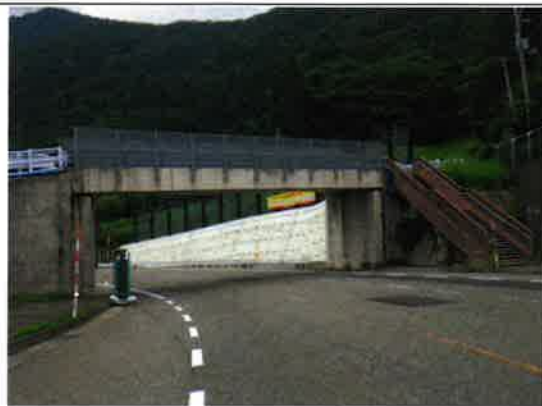
写真全景（コンクリート橋）
