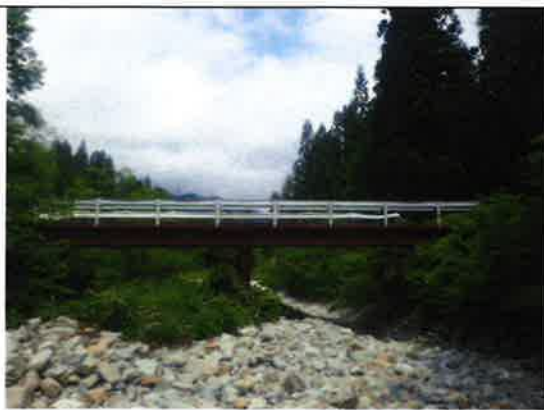
写真全景（鋼橋）
