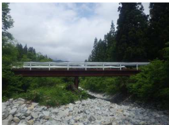
写真全景（鋼橋）
