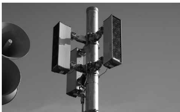
消防サイレン吹鳴スピーカーの改修
