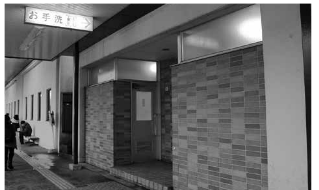
越後湯沢駅東口 駅前トイレの移設・バリアフリー化
